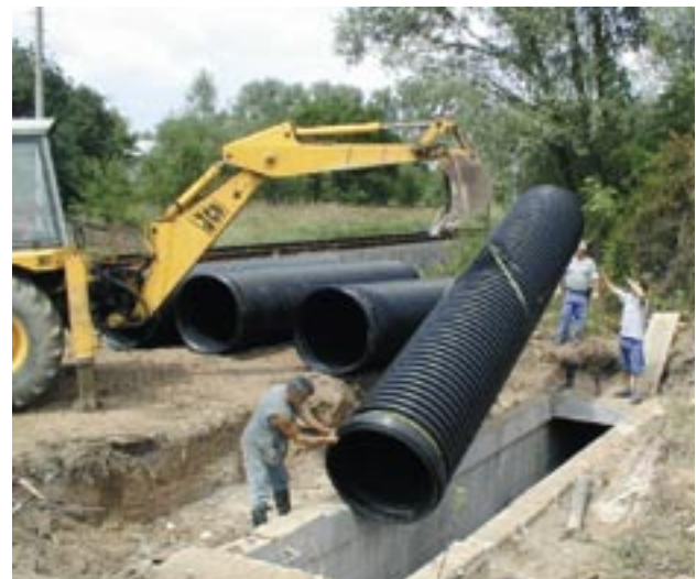
Uponor-putkijärjestelmällä peruskorjataan viemäriverkostoa Tsekin tasavallassa.
