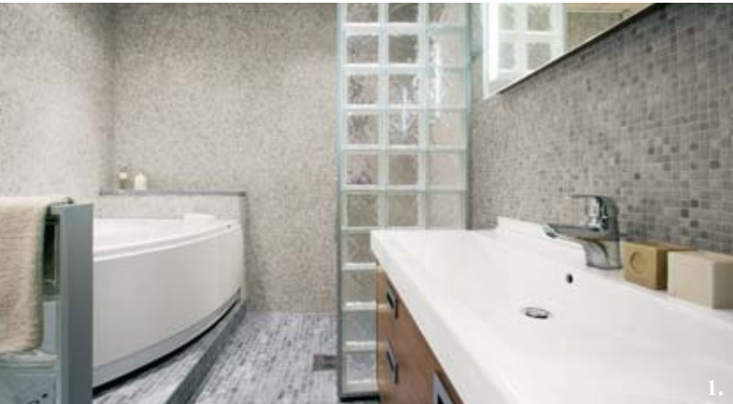
1. Tiilikuvioinen vuolukivimosaiikki elävöittää lattiapinnan. Vuolukivi sopii hyvin kosteisiin tiloihin, koska se ei ole märkänäkään liukas ja varaa hyvin lämpöä. Seinät Cloudy Grey –marmorimosaiikkia.
