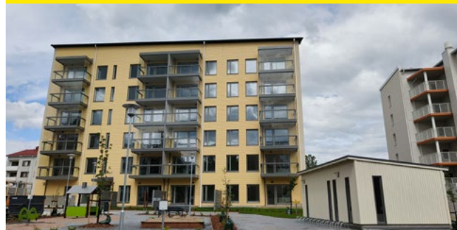
Hippoksenkatu 44 NPS 100 (luovutusvaihe) O-virheluovutus
