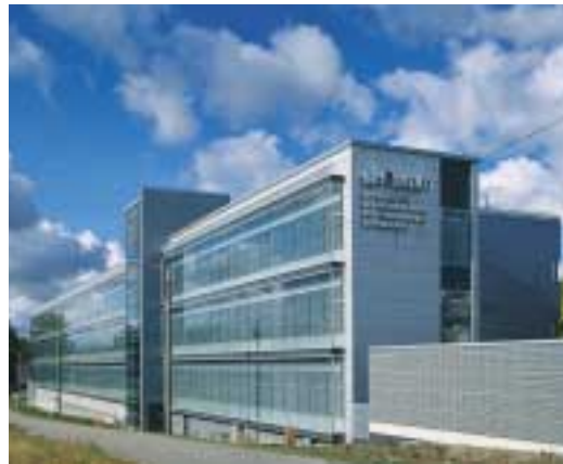
SRV Yhtiöiden uusi toimitalo Espoon Niittykumpussa
