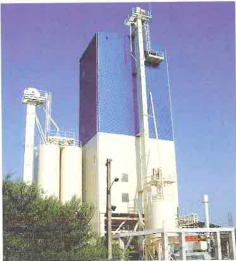
Raute Dry Mix Oy:n Portugalin toimittama laasti- ja tasoitetehtas sisälsi myös kalkkikiven murskaus- ja jauhatusprosessin.
