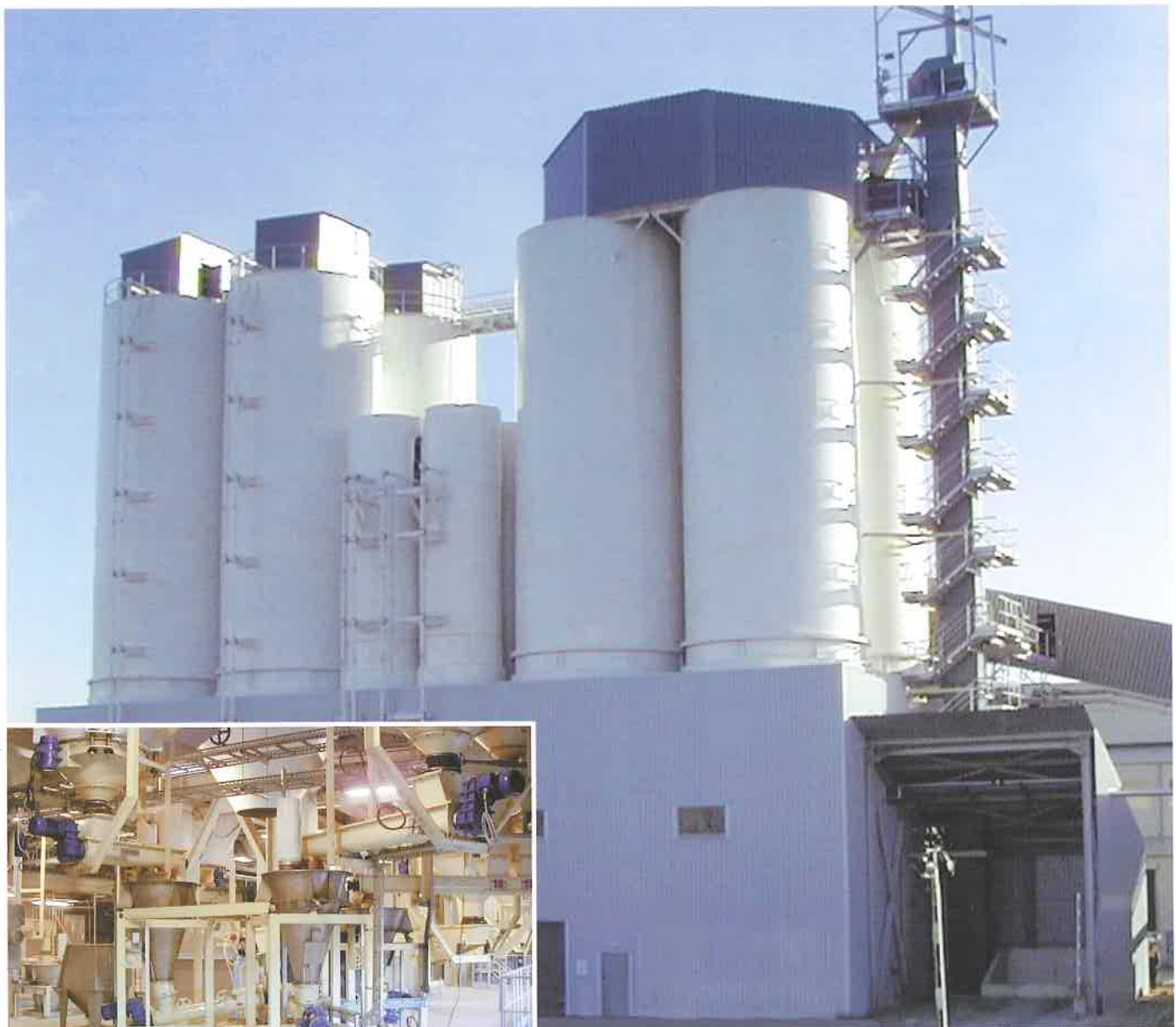
Raute Precision toimitti lasitehtaan raaka-ainelaitoksen ja sirunkäsittelylinjan Saint-Gobain Glass UK Ltd:lle Englantiin.
