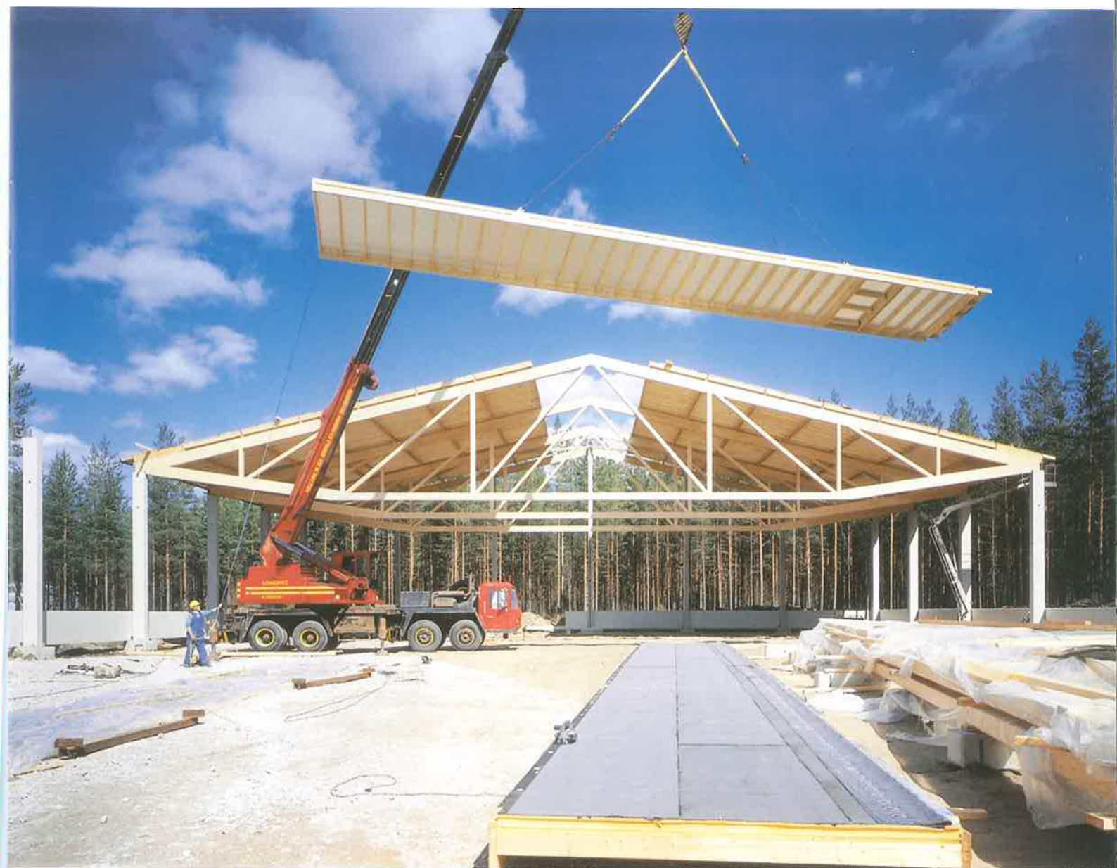
Viilupalkin tyypillisiä käyttökohteita ovat ballit ja suuret rakennukset, joissa vaaditaan pitkiä jännevälejä. Kuvassa Kurikan jäähallin kattotuolien ja -elementtien asennustyö käynnissä. (Kuva Finnforest Oy)
