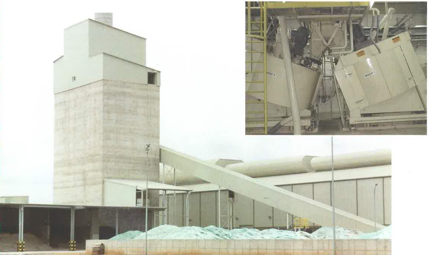
Lasiteollisuusyksikkö toimitti vuoden 1998 aikana menkilaitoksen ja sirunpalautuslinjan Guardianin tasolasitehtaaseen Rio de Janeiroon Brasiliaan.
