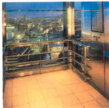
Kaupungit muuttuvat "vihreämmiksi", kun talojen energiaa kuluttavat hissien käyttöjärjestelmät korvataan energiaa säästävällä V3F™-järjestelmällä.
