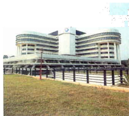
K.K. Hospital, Singapore. Vuonna 1997 valmistuneeseen sairaalaan asennettiin 20 KONE-hissiiä.
